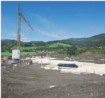
Blick auf die Baustelle des künftigen Flugrettungsstützpunktes. Foto: KD
